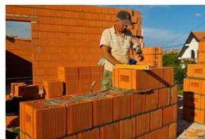
Zidanje opekarskim blokom
