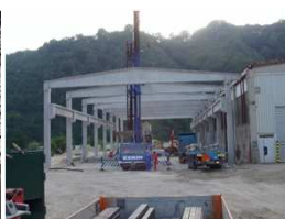
Montažna AB hala
