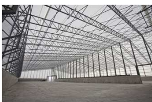
Montažna čelična hala
