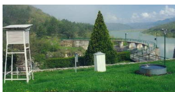
Meteorološki zaklon kod hidrotehničkog objekta
